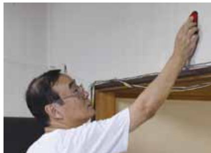
壁裏センサーを使って、壁の中にある下地材(木材や金属)を検知。
